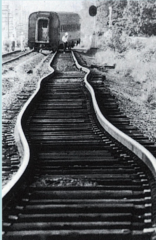
(a) 橋上的伸縮縫，(b) 熱天時鐵路鐵軌呈現彎曲的現象。
